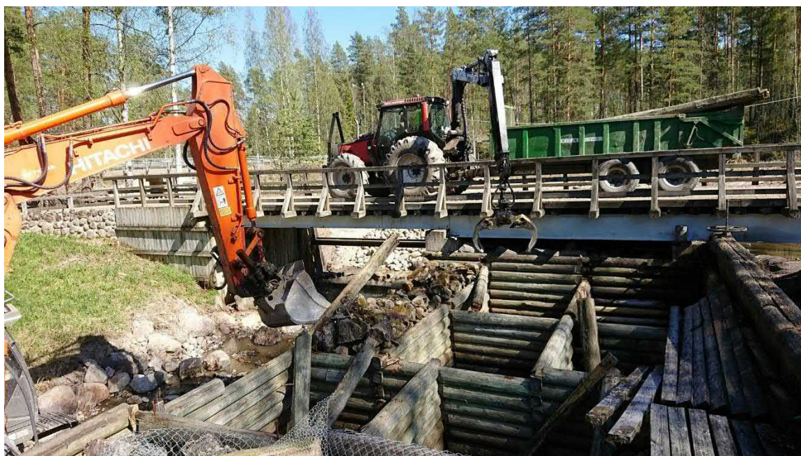
Kuva 13. Hirsikehikon purkaminen (26.5.2020, Jarmo Pautamo)
