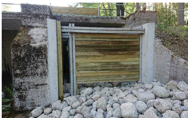
Kuva 12. Säännöstelypadon juoksutusrakenteet (12.6.2020, Jarmo Pautamo)
