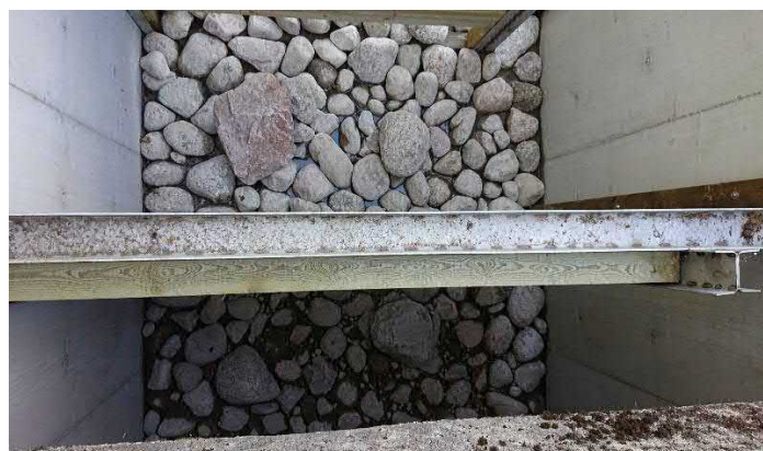
Kuva 12. Säännöstelypadon juoksutusrakenteet (12.6.2020, Jarmo Pautamo)
