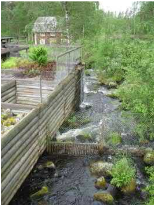
Myllysillalta alavirtaan, 2014. Silta muodosti nousuesteen. Puukehikon vieressä kapea jokiosuus. Kehikon vieressä neliömäinen vesiallas.
