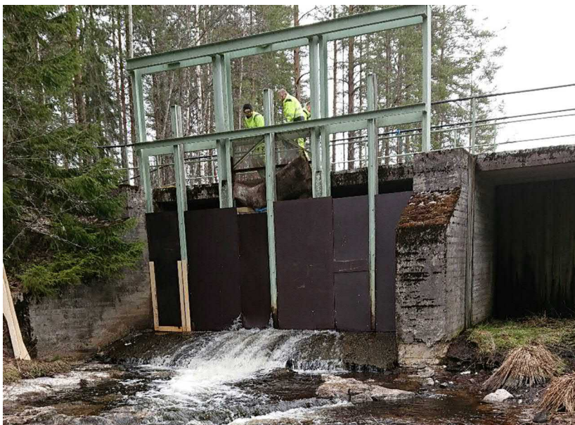
Kuva 6. Koejuoksutus säännöstelypadon vanhasta juoksutusaukosta (14.5.2020, Jarmo Pautamo)
