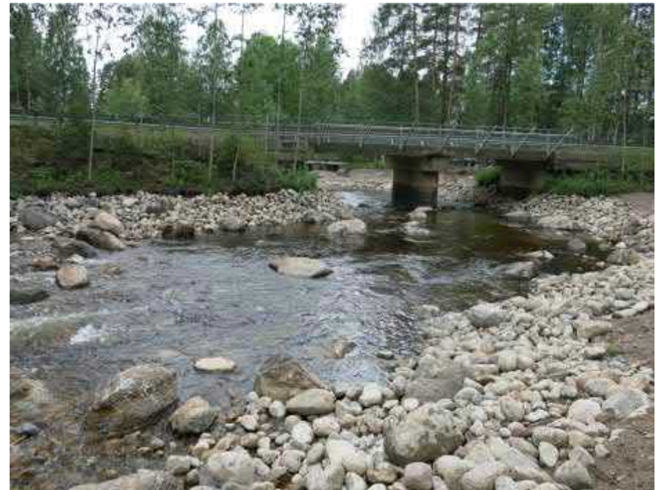
Vuoden 2014 kuvassa oleva lammen kohta vuonna 2020 maantiesiltaan päin kuvattuna. Veden pintaa on laskettu sillan kohdalla (väriero siltpilarissa) ja uoma muokattu kokonaan uusiksi.
