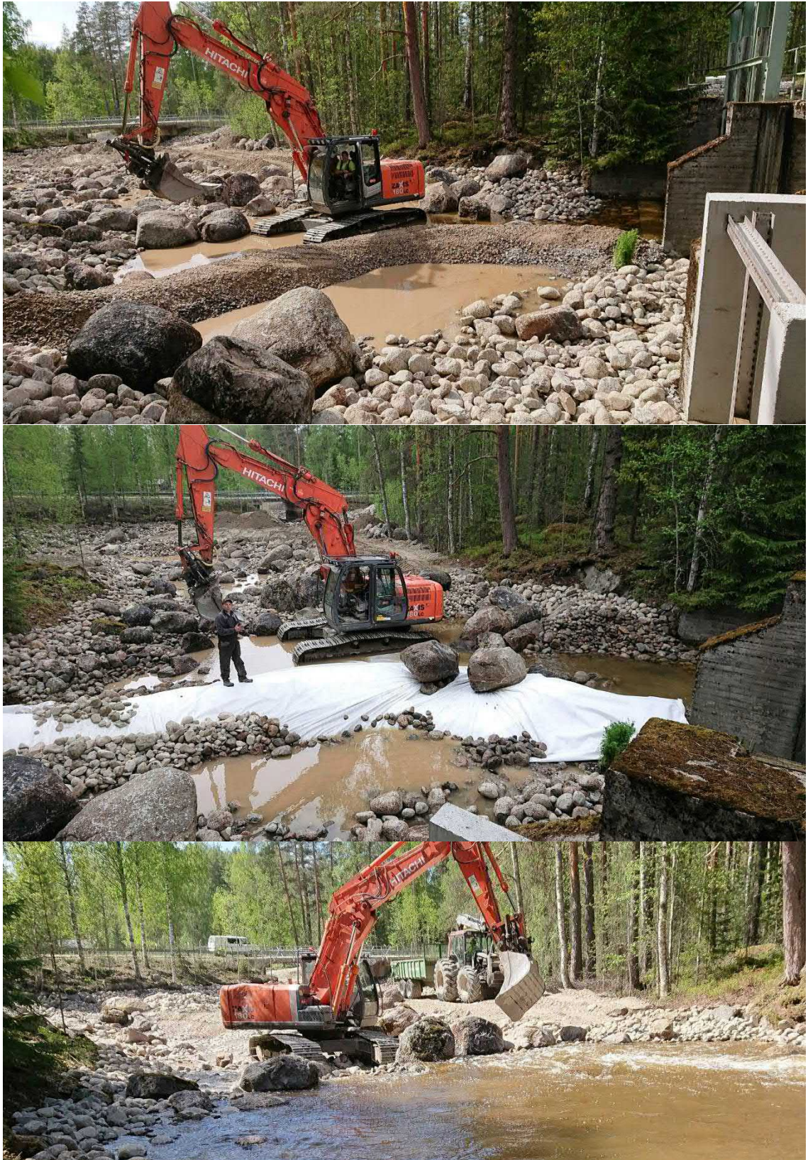
Kuva 9. Kynnyksen rakentaminen säännöstelypadon alapuolelle (2.6.2020, Jarmo Pautamo)
