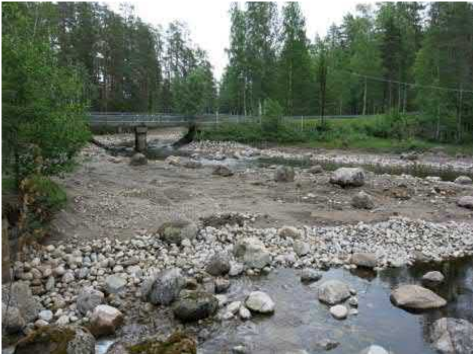
Samalta paikalta 1.7.2020. Lammen paikalle on muokattu joen mutka ja uusi niemi, johon istutetaan puita (osa istutuksista oli tehty jo rannoille 1.7.2020). Veden pintaa on laskettu.
