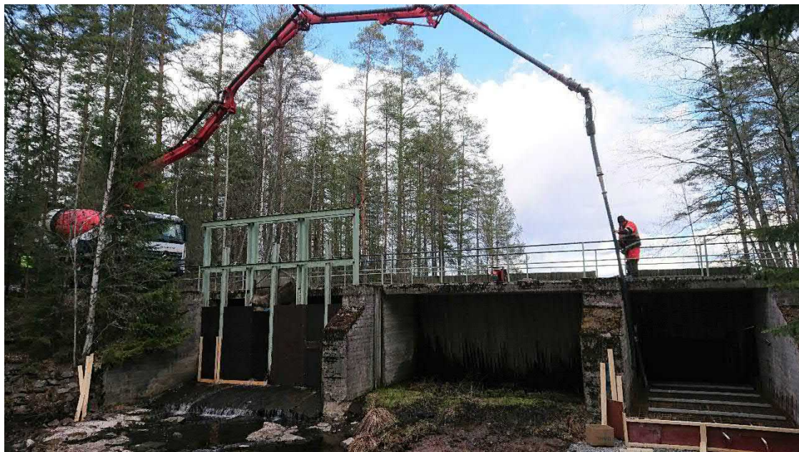
Kuva 11. Säännöstelypadon juoksutusrakenteiden pohjan betonivalu (13.5.2020, Jarmo Pautamo)
