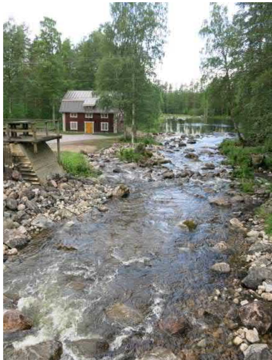
Myllysillalta alavirtaan, 2020. Sillan alus avattu ja nousueste poistettu. Puukehikko purettu, pöytä jätetty vielä. Veden pinnan laskiessa ja rakenteiden purkamisen myötä allas poistui. Uoma leventyi.
