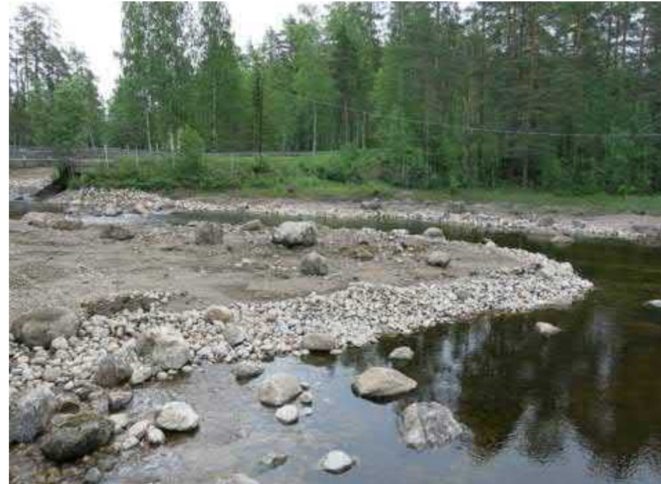
Samalta paikalta 1.7.2020. Lammen paikalle on muokattu joen mutka ja uusi niemi, johon istutetaan puita (osa istutuksista oli tehty jo rannoille 1.7.2020). Veden pintaa on laskettu.
