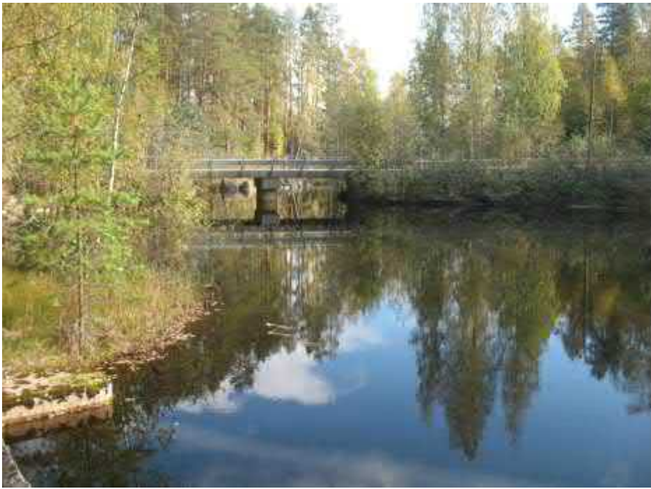
Myllysillalta maantiesillalle, kokonaan lampimainen alue 2014.
